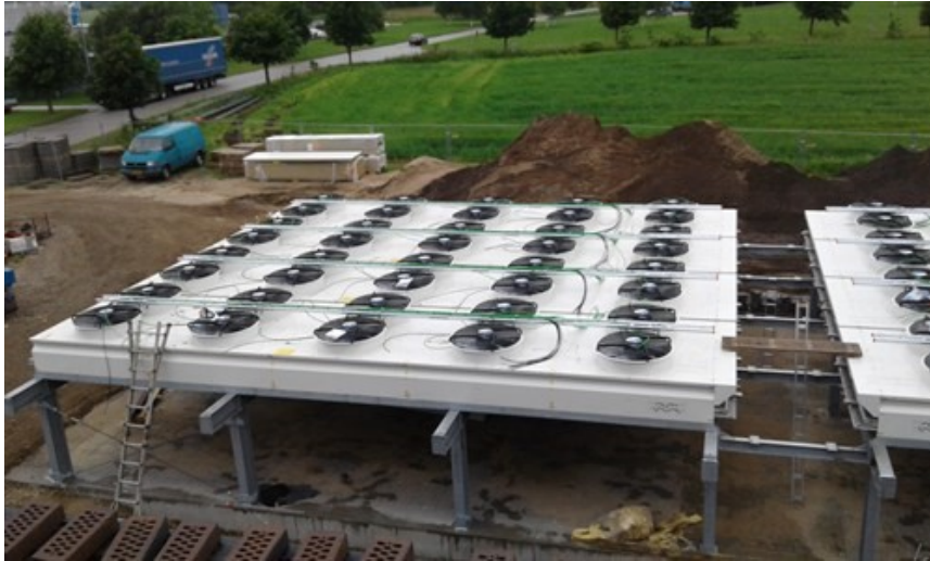
Figur 8.3 – Billede af udeluftkølerne i Tønder.
