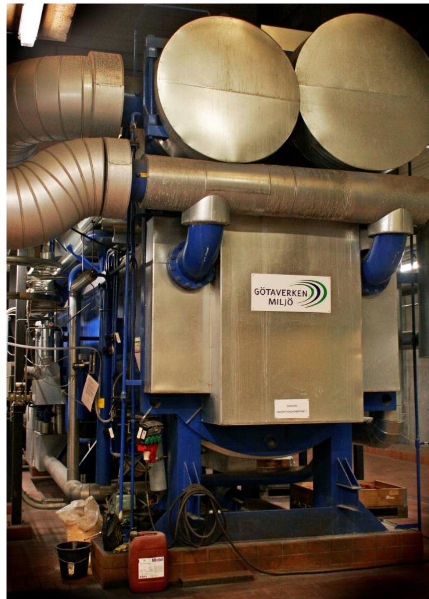
Figur 2.10 – Absorptionsvarmepumpe ved Vestforbrænding.
