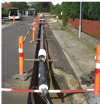
Figur 6 Etablering af nyt fjernvarmenet i Sønderby
