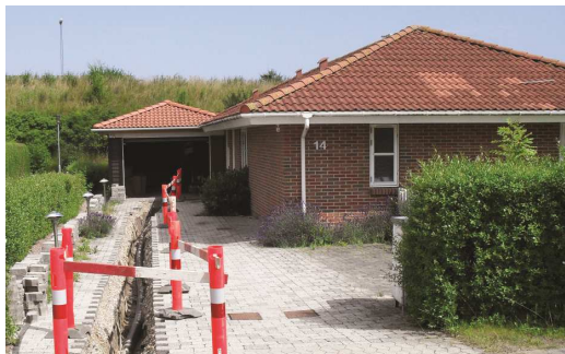
Figur 5 Etablering af ny stikledning til et af demonstrationshusene i Sønderby, Høje-Taastrup
